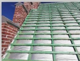
Nadkroevní izolace šikmé střechy
