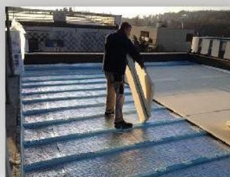
Izolace ploché střechy
