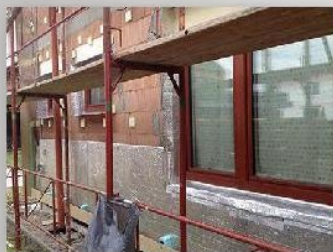
Izolace zdiva z pálených cihel v exteriéru
