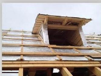
Nadkroevní izolace šikmé střechy
