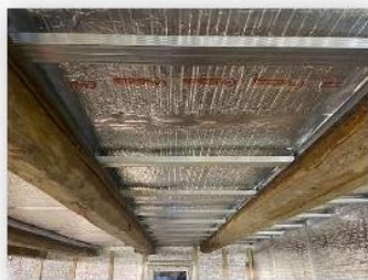
Izolace stropu s pohledovými trámy
