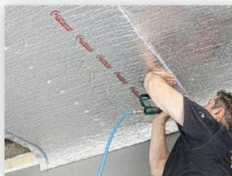
Izolace stropu s nepochozí půdou
