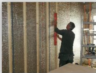
Izolace příčky v dřevostavbě
